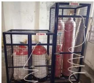
**Fig. 3.4.2: Cylinder Cage**
